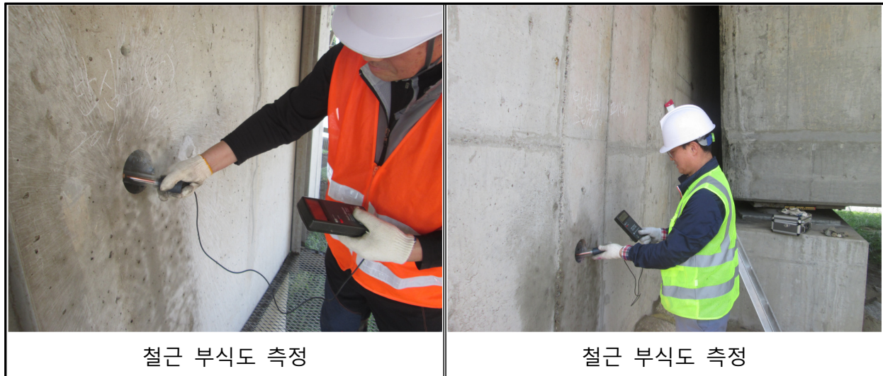
&lt;사진 4.5&gt;철근 부식도 측정 사진
