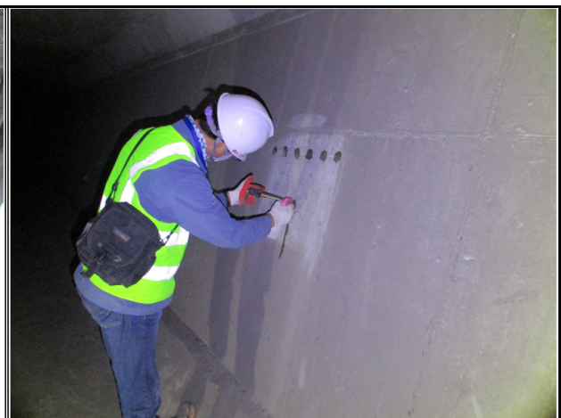
콘크리트 탄산화 깊이조사
