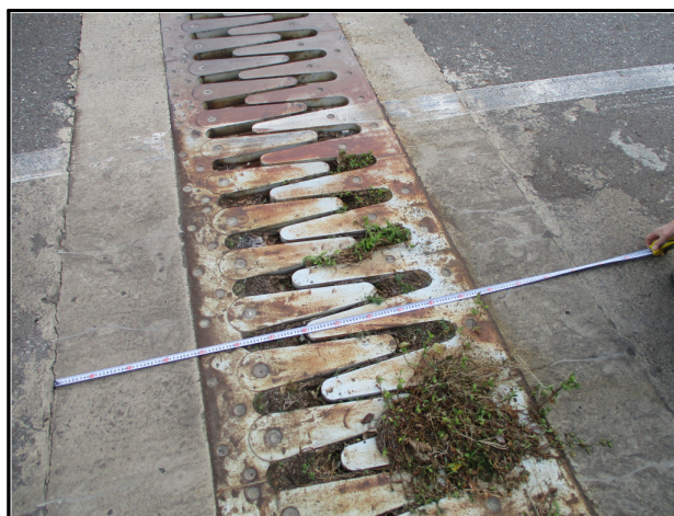
신축이음 유간거리 측정(A1)
