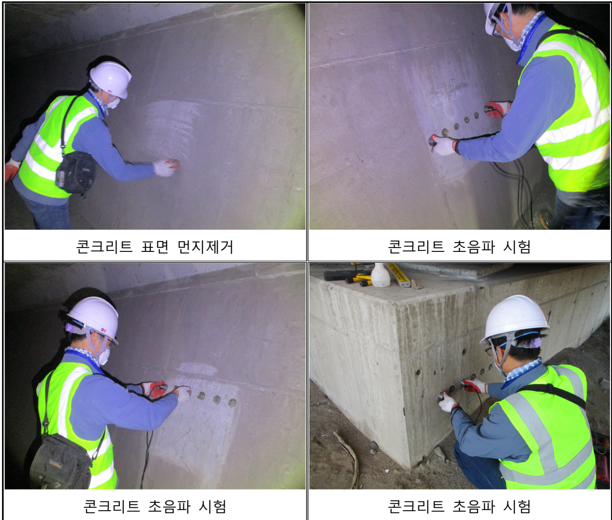
<사진 4.2>콘크리트 초음파 시험 사진
