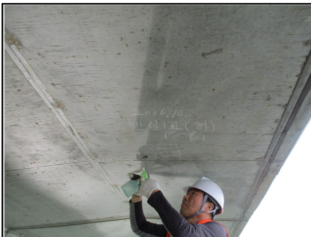
콘크리트 탄산화 깊이조사
